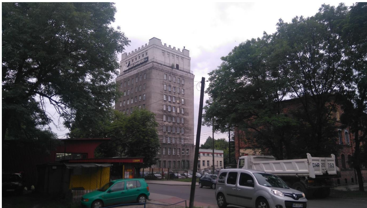
Zdjęcie 8 Osiedle Warty - stary budynek biurowy Huty Zawiercie
